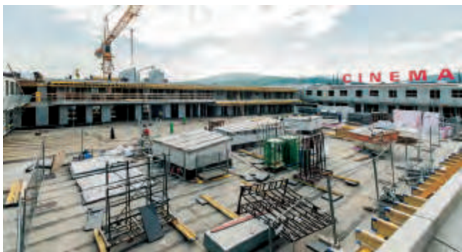
Auch so kann ein Baurecht aussehen: Auf dem Dach des Wiener Einkaufszentrums Auhofcenter entstehen geförderte Wohnungen
